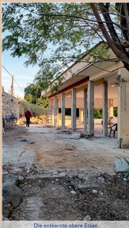
Die entkernte obere Etage.
