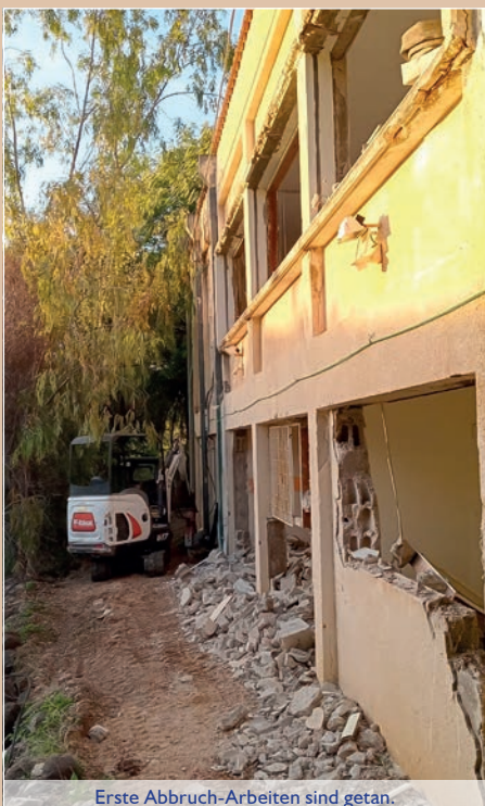
Erste Abbruch-Arbeiten sind getan.
