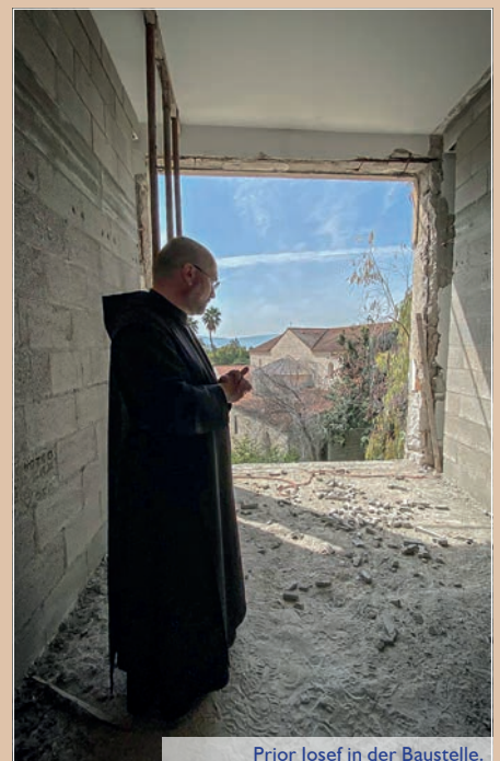
Prior Josef in der Baustelle.
