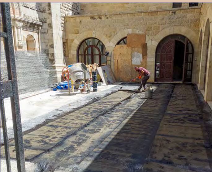
Vor allem die westliche Seite des Hofes musste neu verdichtet werden, um weitere Wasserschäden im Bibliotheksraum darunter zu vermeiden (11. August 2022).
