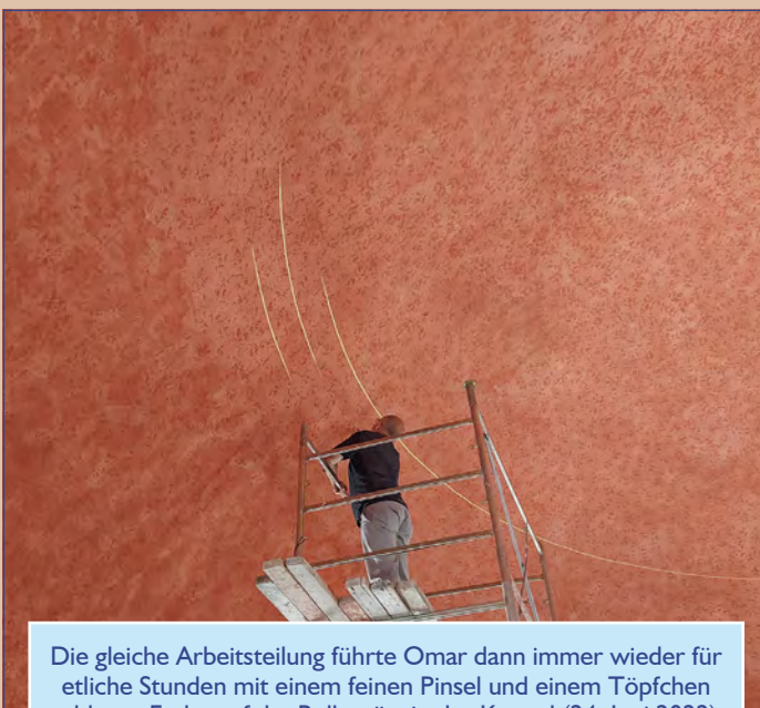
Mit einer Art Stempel brachte George eine weitere, strukturierte Schicht in kräftigerem Rot auf, wodurch die Kuppel in sich lebendiger und organischer wurde (6. Juni 2022).
