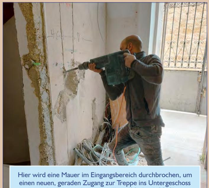
Hier wird eine Mauer im Eingangsbereich durchbrochen, um einen neuen, geraden Zugang zur Treppe ins Untergeschoss mit den Pilgertoiletten zu öffnen (20. April 2022).
