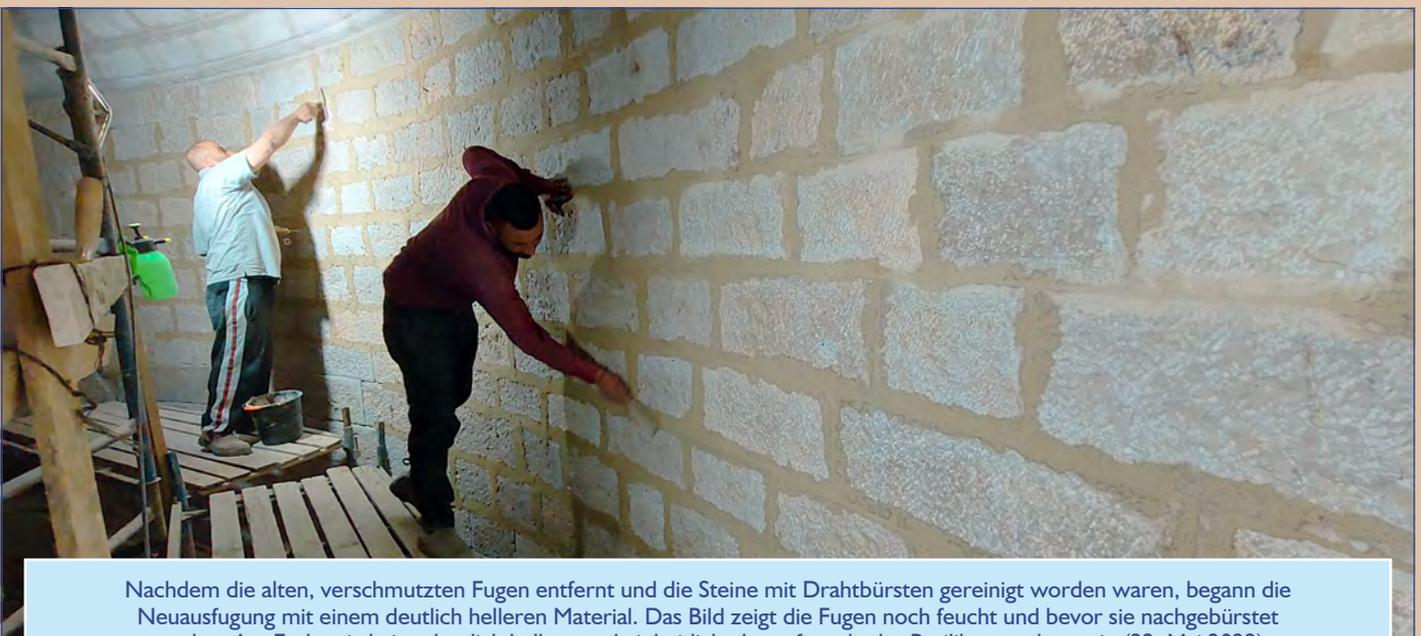
Nachdem die alten, verschmutzten Fugen entfernt und die Steine mit Drahtbürsten gereinigt worden waren, begann die Neuaufugung mit einem deutlich helleren Material. Das Bild zeigt die Fugen noch feucht und bevor sie nachgebürstet wurden. Am Ende wird eine deutlich hellere und einheitliche Innenfassade der Basilika zu sehen sein (22. Mai 2022).
