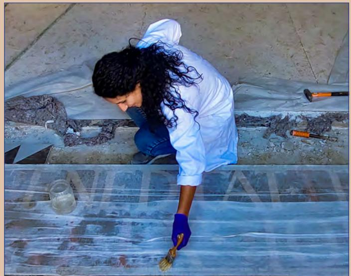
Das Mosaik wurde von oben fixiert, von seinem Untergrund abgelöst und dann zwischengelagert. Es wird später an etwas veränderter Position wieder eingesetzt werden (19. Mai 2022).
