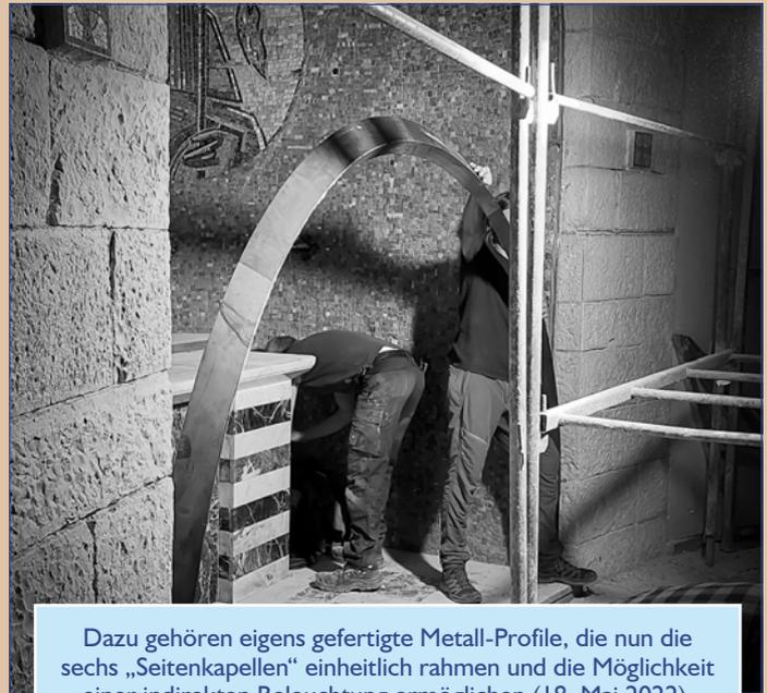
Dazu gehören eigens gefertigte Metall-Profile, die nun die sechs „Seitenkapellen“ einheitlich rahmen und die Möglichkeit einer indirekten Beleuchtung ermöglichen (18. Mai 2022).
