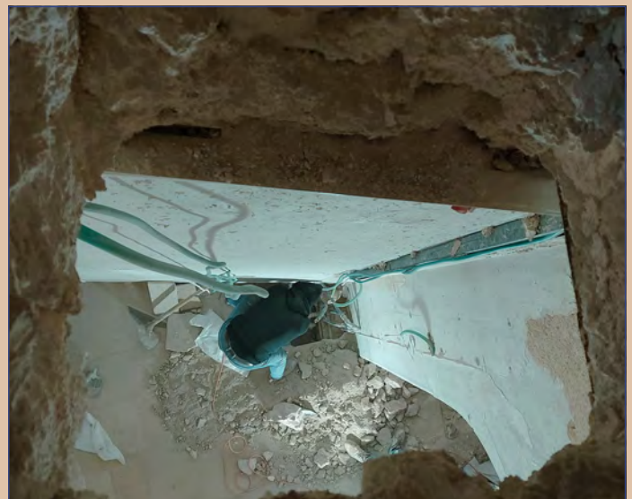
An markanten Stellen gibt es aktuell neue Durchbrüche in Decken/Böden und Wänden, damit die Installationen auf geradem Weg erfolgen können (9. Februar 2022).
