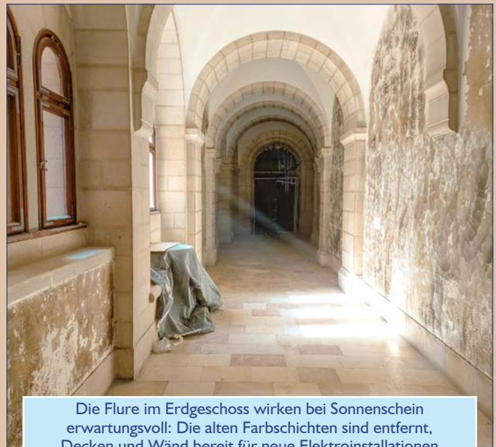
Die Flure im Erdgeschoss wirken bei Sonnenschein erwartungsvoll: Die alten Farbschichten sind entfernt, Decken und Wände bereit für neue Elektroinstallationen und frische Farbe (14. Dezember 2021).
