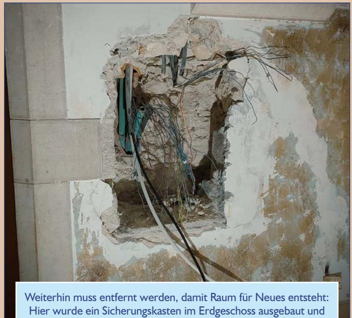
Weiterhin muss entfernt werden, damit Raum für Neues entsteht: Hier wurde ein Sicherungskasten im Erdgeschoss ausgebaut und hinterlässt vorerst ein Loch in der Wand (17. Januar 2022).
