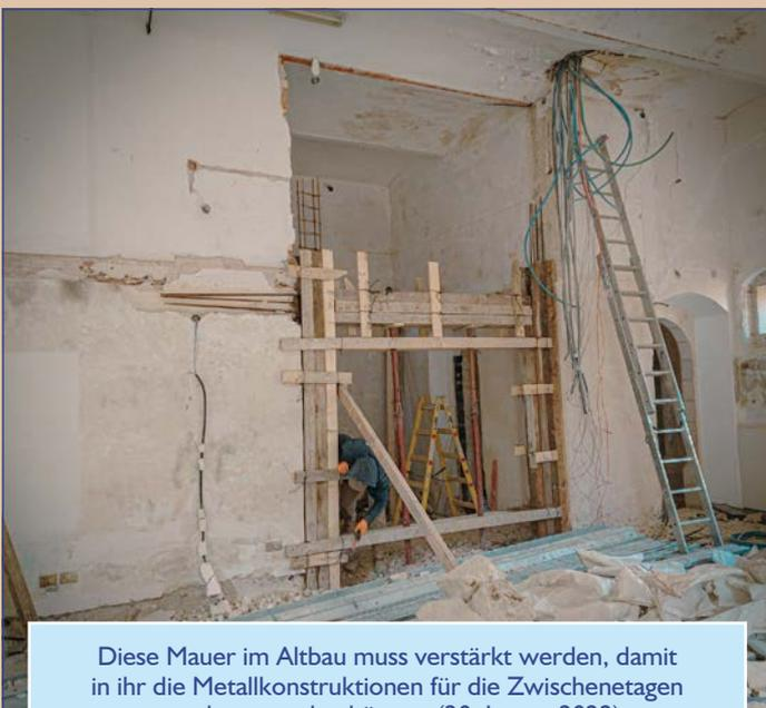
Diese Mauer im Altbau muss verstärkt werden, damit in ihr die Metallkonstruktionen für die Zwischenetagen verankert werden können (20. Januar 2022).
