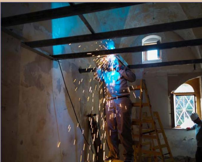
Die Schweißarbeiten für die kleinen Zwischenetagen in den Mönchszellen im Altbau schreiten voran (30. Dezember 2021).
