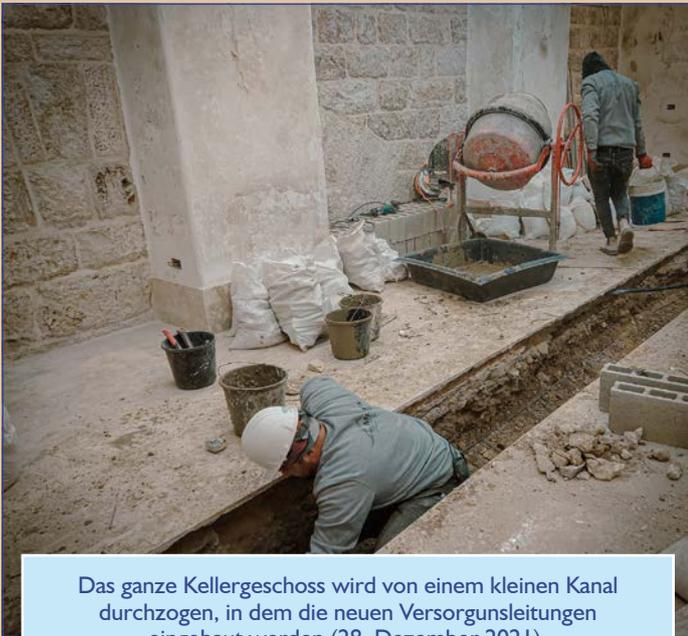
Das ganze Kellergeschoss wird von einem kleinen Kanal durchzogen, in dem die neuen Versorgungsleitungen eingebaut werden (28. Dezember 2021).
