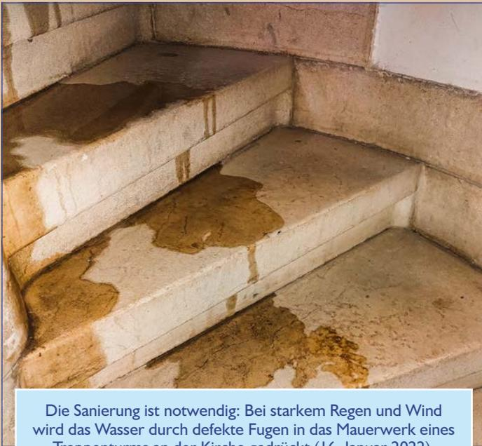
Die Sanierung ist notwendig: Bei starkem Regen und Wind wird das Wasser durch defekte Fugen in das Mauerwerk eines Treppenturms an der Kirche gedrückt (16. Januar 2022).
