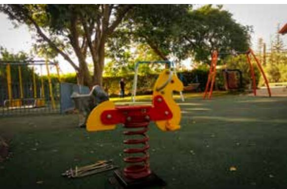
Als letztes wurden die beiden kleinen Feder-Wipp-Tierchen für die Aller kleinsten installiert.
