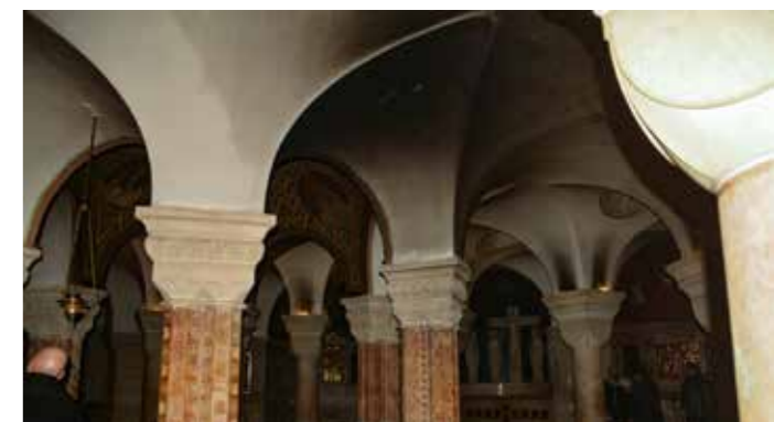
Besonders das Gewölbe über dem Kerzenstand an der Marienfigur der Krypta ist stark verrußt.
