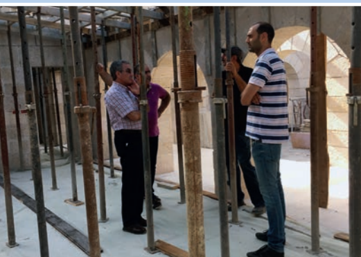
Ende Juli 2016: Offene Stahl-Beton-Decken sollen die beiden Seitenflügel künftig besser sichern. In den offenen Umgängen wird sich optisch nichts verändern: Sie werden wieder mit einer Holzdecke versehen. – Kahlil und Shadi Dowery sowie Walid und Nassim Haj betreuen einmal mehr Tabgha.
