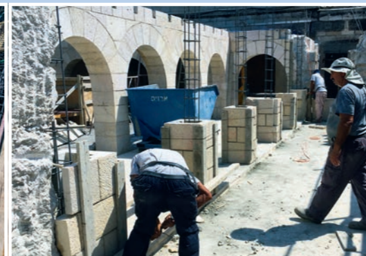
September 2016: Einige der Mauerteile waren durch das Feuer so stark beschädigt, dass sie komplett abgerissen und neu errichtet werden mussten, auch hier mit neuen Stahlkernen. Der Fußboden im Bereich von Pforte und Diwan war ebenfalls völlig zerstört und musste erneuert werden.
