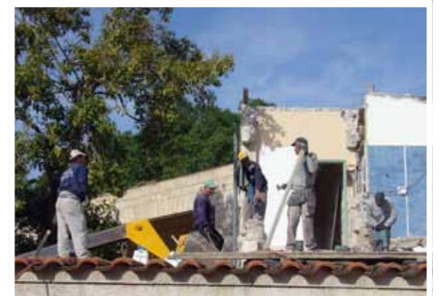
Nachdem das Haus leerräumt, Bäume gefällt und Ziegel und Fenster abgebaut waren, wurde es ernst...
