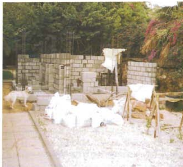
Das neue Toilettenhaus im Bau
