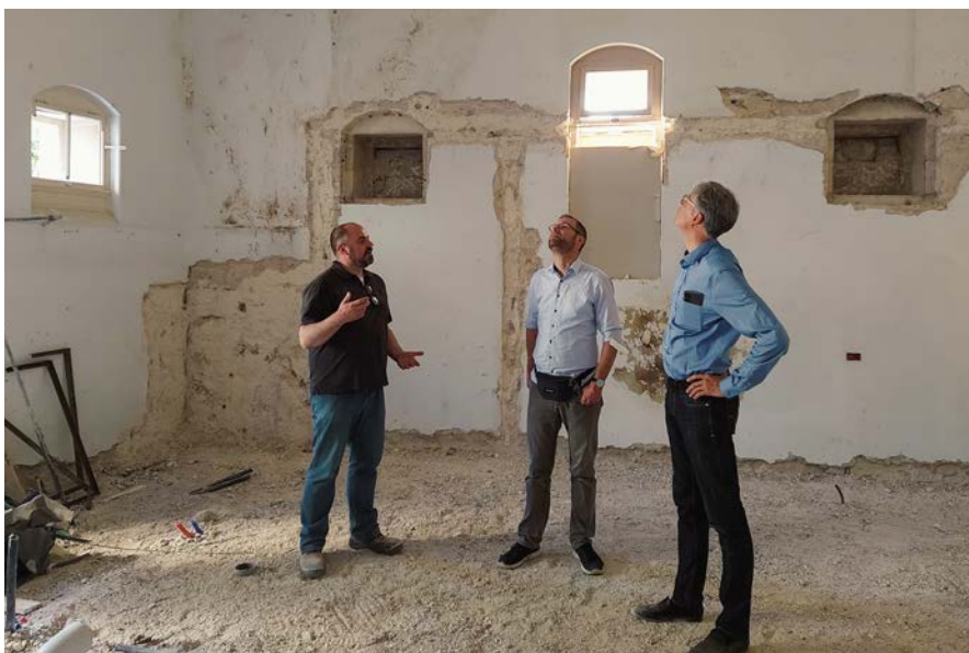
Baustellenbegehung in der Dormitio: Pater Basilius mit Matthias Vogt und Martin Struck (v.l.n.r.).
