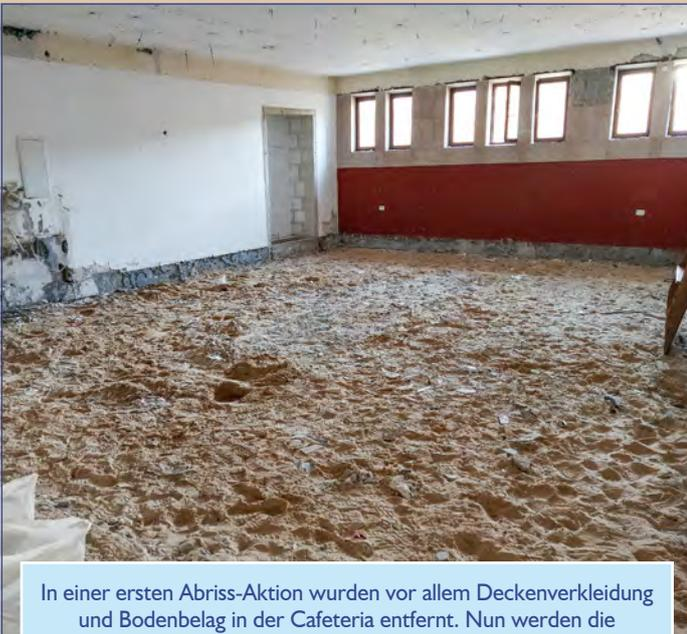
In einer ersten Abriss-Aktion wurden vor allem Deckenverkleidung und Bodenbelag in der Cafeteria entfernt. Nun werden die Fenster vergrößert und ein neuer Eingang angelegt.
