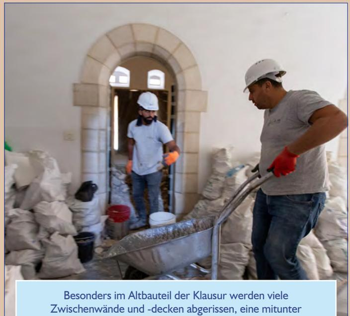
Besonders im Altbauteil der Klausur werden viele Zwischenwände und -decken abgerissen, eine mitunter mühsame, vor allem laute und staubige Arbeit.
