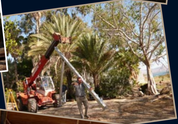
Die alte Bedachung war zu angerostet, um sie stehen zu lassen.
