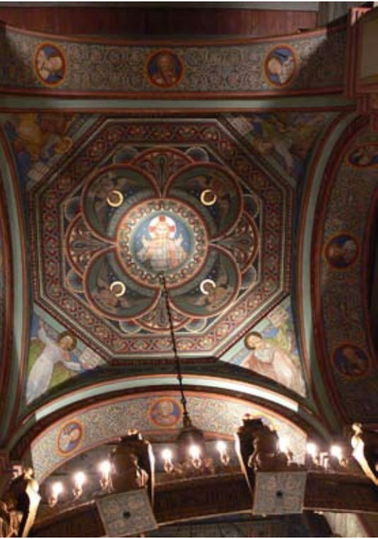
In der Godehards-Basilika akzentuiert eine neue Beleuchtung die Schwerpunkte der Kirche.
