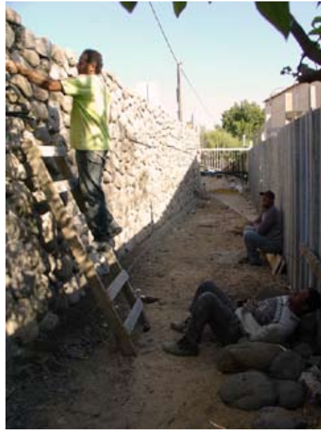
Während des Baus der neuen „Klausur-Mauer“ entlang der Hauptstraße.
