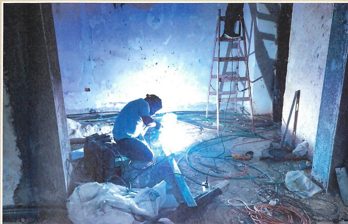
Im Wohnbereich der Mönche sind verschiedene Arbeitsschritte und Handwerker nötig.
