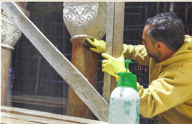
Alle Bauteile im Inneren der Basilika werden gereinigt und erstrahlen fast wie neu.
