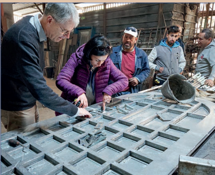
Nach dem Fest gingen die Arbeiten wieder weiter. - Hier sind Martin Struck und Raja Shbeita bei unserem Schlosser Elias, um eine der neuen Türen zu begutachten (23. März).
