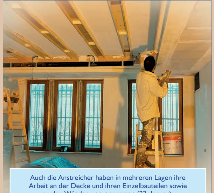
In der Cafeteria wurde in mehreren Schritten eine abgehängte Decke installiert, die zum einen Schall dämmt und zum anderen Teile der Haustechnik verbirgt (17. Januar).
