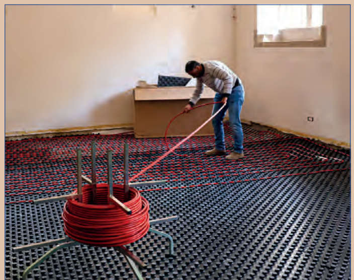
Bevor der neue Steinboden verlegt werden kann, wird unser Refektorium mit einer Fußbodenheizung ausgestattet (13. Dezember).
