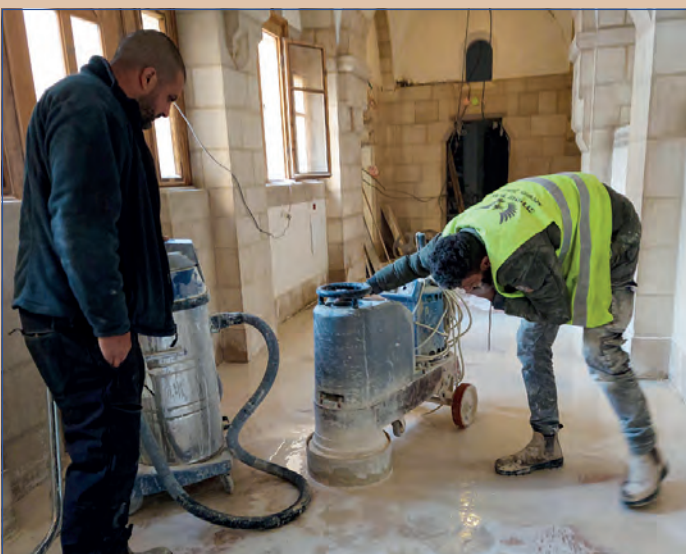
Eine Reihe der ursprünglichen Steinböden in den Korridoren wurden ausgebessert, abgeschliffen und neu poliert (3. Januar).
