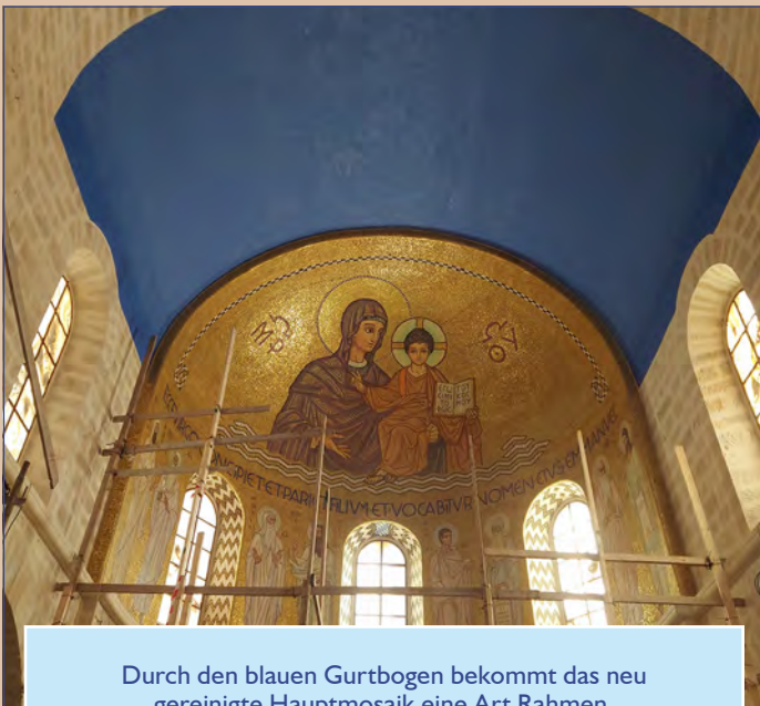
Den blauen Grundanstrich haben unsere Handwerker vorgenommen. Bau-Mönch Basilius hat danach noch Strukturen und Akzente eingebracht.
