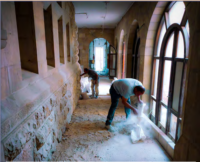
Eine der wichtigsten Rampen: Sie führt von der Kirche zur Eingangs-Ebene mit Pforte, Cafeteria und Laden. Ali bereitet sie für die Fliesen vor (27. Oktober).
