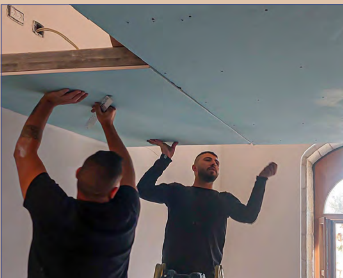
Auch die „Gips-Bauer“ sind immer wieder im Einsatz, um Wände und Decken in dieser Trockenbauweise einzusetzen (26. Oktober).
