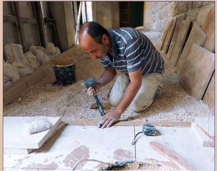
Die gleiche Rampe, dieses Mal von „unten“. Fliesenleger Abu Issa verlegt im Wechsel glatte Steine und schmalere, raue Streifen, um die Rutschgefahr zu minimieren (27. Oktober)
