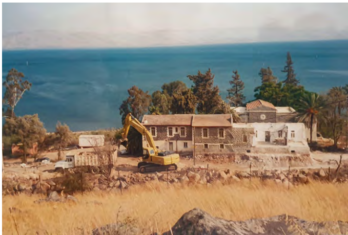
Eine weitere Tabgha-Baustelle: Das Pilgerhaus wurde erneuert und maßgeblich vergrößert.
