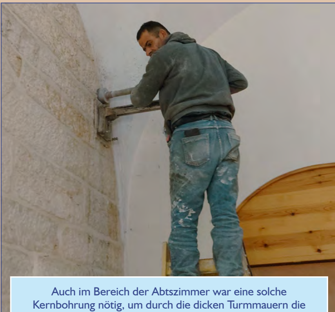
An etlichen Stellen im Gebäude wurden solche großformatigen Bohrungen vorgenommen, durch die später v.a. verschiedene Wasserleitungen bzw. -rohre führen werden (14. März 2022).
