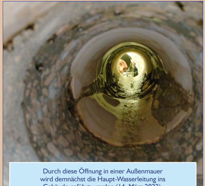
An etlichen Stellen im Gebäude wurden solche großformatigen Bohrungen vorgenommen, durch die später v.a. verschiedene Wasserleitungen bzw. -rohre führen werden (14. März 2022).
