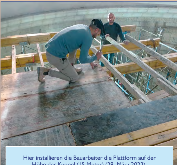
Am 10. März begann die Innen-Einrüstung der Kirche: In der Mitte steht ein „Turm“, der eine Plattform trägt, am Rand gibt es einen zusätzlichen Ring für die Arbeiten an den Mauern.
